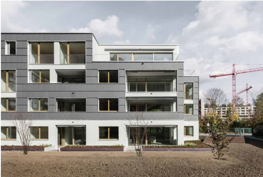
Mehrfamilienhaus in Zürich Leimbach: Die matten PV-Paneele auf der Fassade sind erst aus der Nähe als solche zu erkennen.
