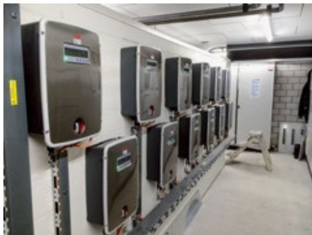
Die Wechselrichter stehen in der Energieversorgung des Mehrfamilienhauses zwischen Produktion und Verbrauch.
