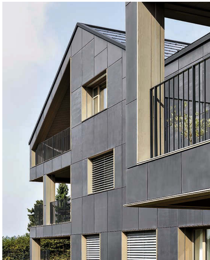
Monolithischer Charakter: Kein Bauteil soll in Brütten Schatten auf die Fassade werfen, die mit ihren matten Solarpaneelen einen wichtigen Teil der Energie produziert.
