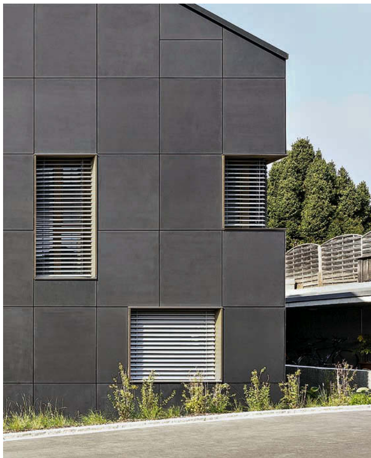
Monolithischer Charakter: Kein Bauteil soll in Brütten Schatten auf die Fassade werfen, die mit ihren matten Solarpaneelen einen wichtigen Teil der Energie produziert.
